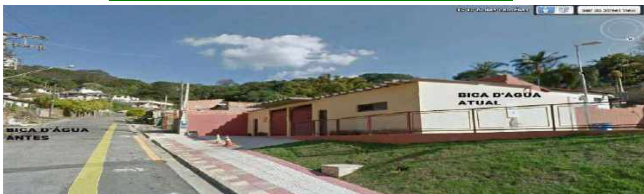
Figura 2 - Local da bica d'água. Rua das Camélias - Bairro Jardim Suíça Paulista em São Roque. Fonte: Google Earth, 2016.
