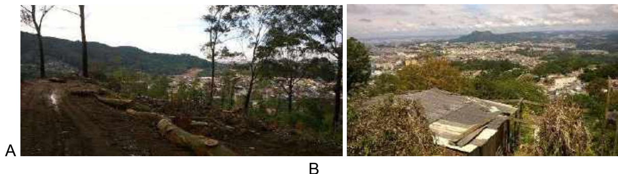
Figura 01: A - Parcelamento irregular do solo urbano no bairro Sitio Botuquara, São Paulo (SP). B - Construções precárias em área de risco na Serra da Cantareira São Paulo (SP).
