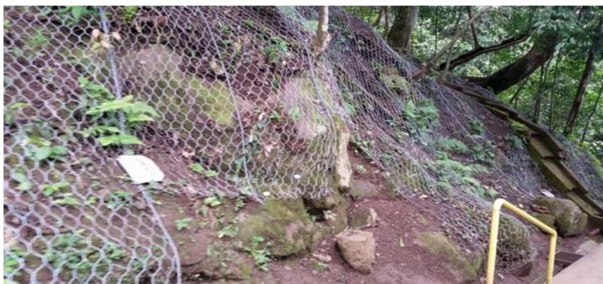
Figura 5. Ação preventiva para evitar erosão e rolagem de pedras no terreno em declive. Fonte: dos autores, 2018.
