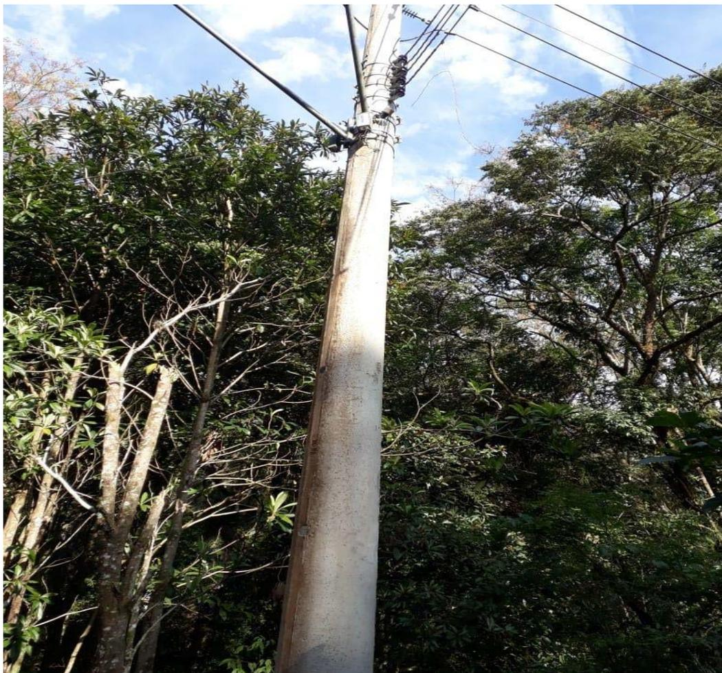
Figura 4: Poste instalado em local indevido
